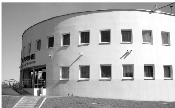
Камеры на переднем фасаде здания: контроль периметра объекта, открытых теннисных кортов
