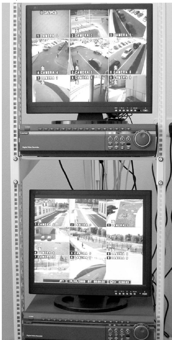
Система записи и отображения видеоданных в помещении сотрудника круглосуточной охраны
