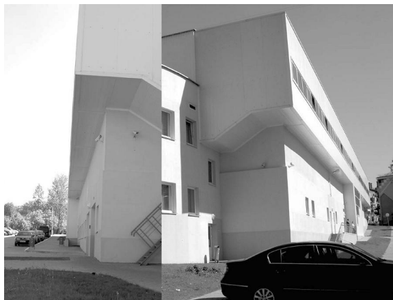
Намеры на боковых фасадах здания: контроль доступа в служебные помещения, периметра объекта, парковки
