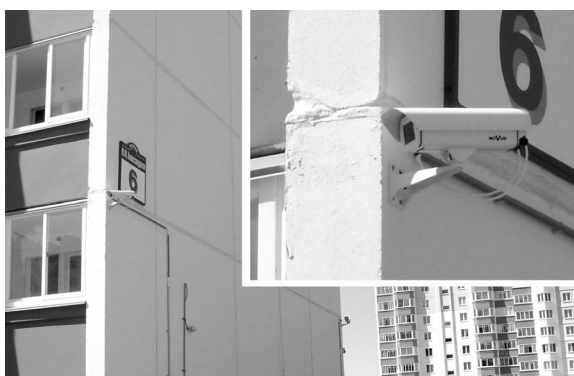
Камеры контролируют въезд/выезд с дворовой территории, парковку перед домом
