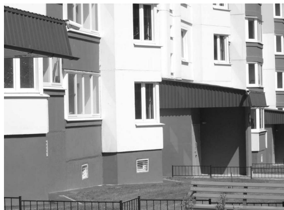
Камеры на козырьках подъездов отслеживают вход/выход из дома, территорию, прилегающую к подъезду
