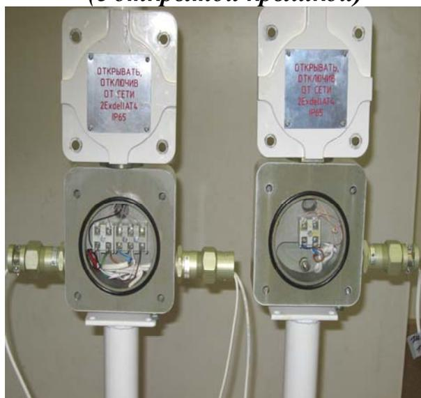
Извещатель рекомендуется для использования на открытых площадках, имеющих металлическое или железобетонное ограждение высотой не менее 2,0 м, а также в помещениях наземных сооружений из кирпича, железобетона или металлических конструкций. Конструктивно извещатель состоит из блока приемника (ПРМ), блока передатчика (ПРД). Блоки на объекте устанавливаются на опорах.
