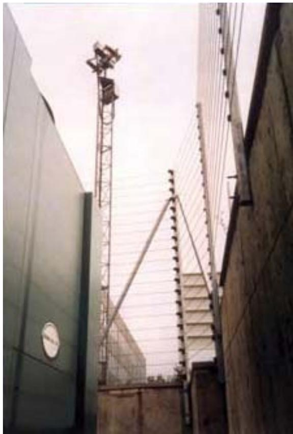
Принцип работы извещателя основан на регистрации изменения натяжения специального чувствительного кабеля. Кабель имеет очень прочную стальную центральную жилу (*многожильный трос из нержавеющей стали*), благодаря которой, после установки его на участке периметра, создается не только зона обнаружения, но и физический барьер.
