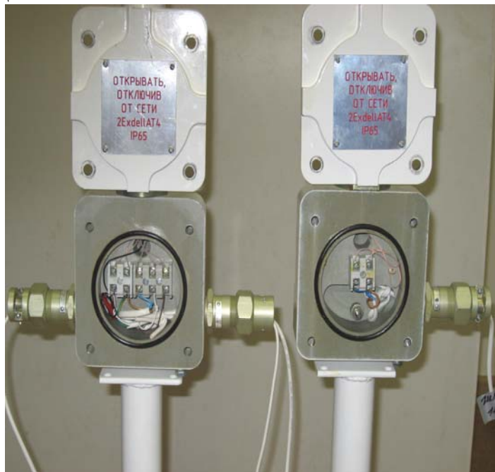
Внешний вид извещателя (с открытой крышкой)
