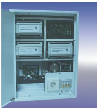
Комплект оборудования для мониторинга удаленных подстанций
