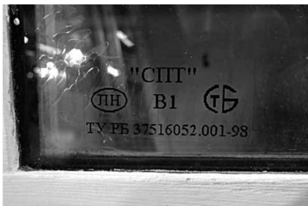
Рис. 3 Пулестойкое стекло после 10 лет эксплуатации со следами расслоения
