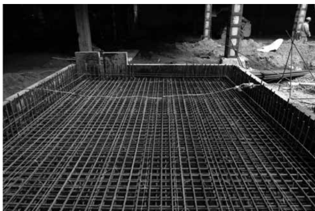
Рис. 1 Будущее хранилище ценностей – подготовка основания
