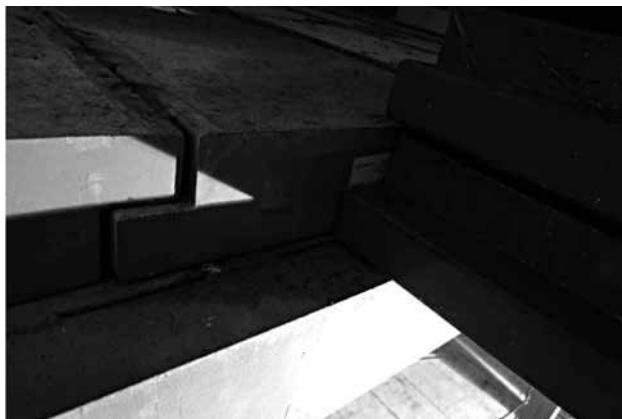
Рис. 12 Сборное хранилище ценностей – соединение модулей
