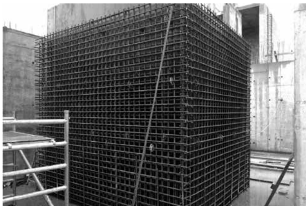
Рис. 6 Армирование стеновых конструкций хранилища ценностей
