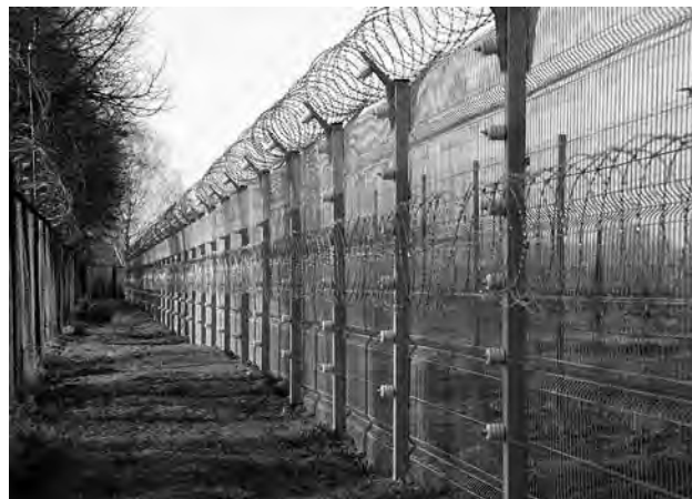
Рис. 4. «СНЭВ» на инженерном ограждении типа «Махаон»
