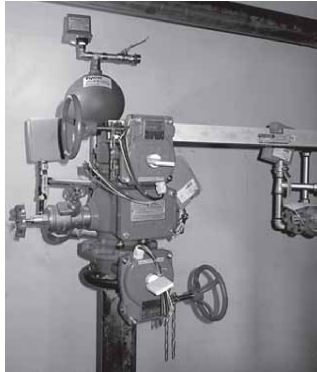
Рис. 4. Насос системы автоматического пожаротушения
