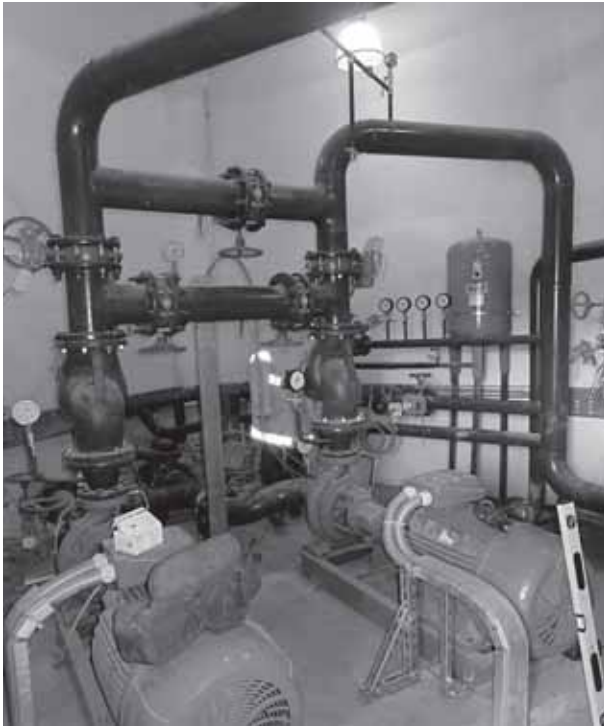
Рис. 3. Обвязка насоса – жокея с мембранным баком
