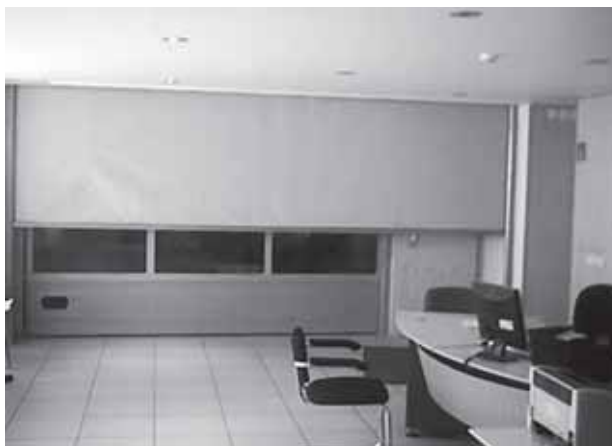
Рис.4. Противопожарная штора в момент закрытия
