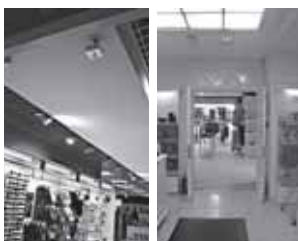
Рис. 8, 9. Примеры установки 2D-видеосчетчиков на реальных объектах
