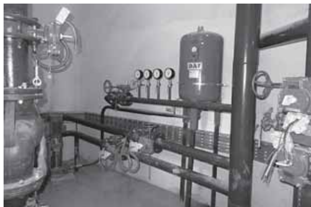
Рис. 2. Обвязка узлов управления ТУСО
