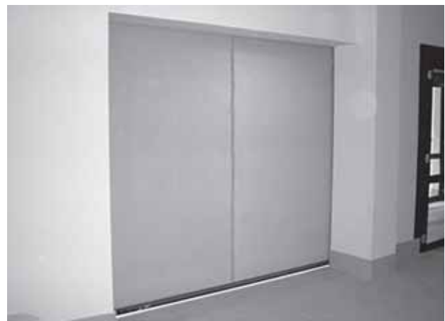
Рис.2. Противопожарная штора в закрытом состоянии
