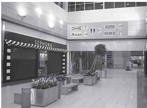
Рис.1. Противопожарная штора в переходе торгового центра
