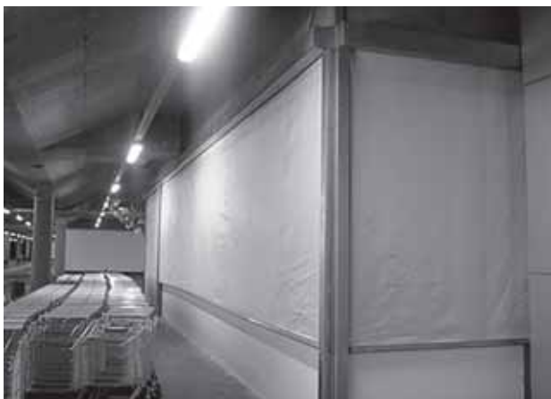
Рис.3. Противопожарная штора в паркинге торгового центра
