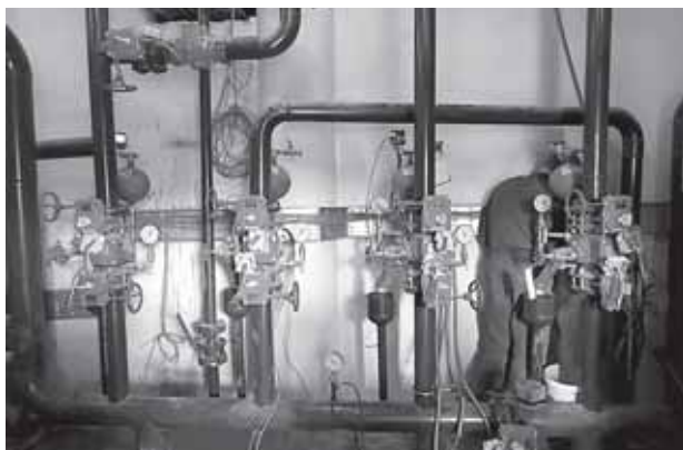
Рис. 1. Обвязка узлов управления ТУСО
